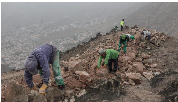
Figura 2 - Operários trabalhando na demolição do “Muro da Vergonha”, em Lima Berlin (ANSA)
