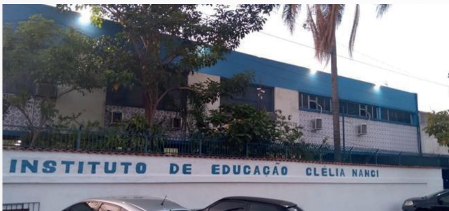
Imagem 2 - Fachada do IECN
