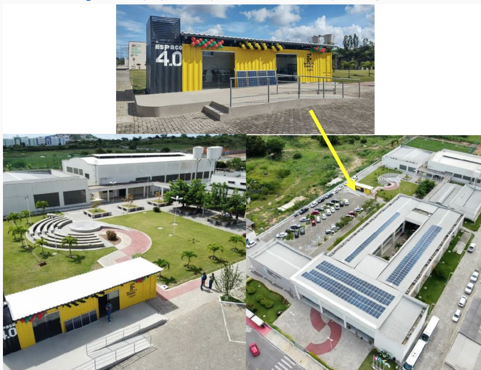
Figura 2. Espaço 4.0 implantado no Ifal Campus Arapiraca.
