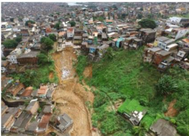
Figura 9 - Deslizamento de terra na comunidade Barro Branco.
