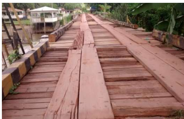
Figura 02: Ponte sobre o Igarapé Furo do Suspiro - em 08/09/2016
