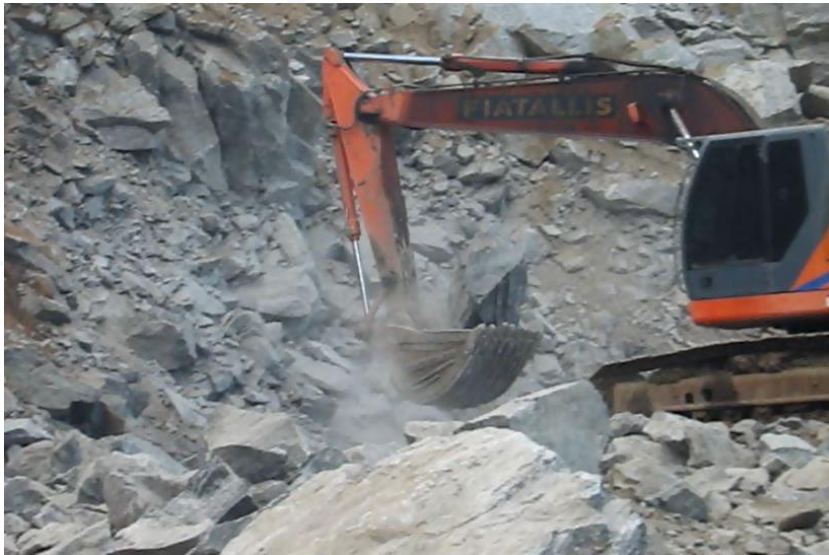
Figura 10. Carregamento de uma frente de lavra, repleta de matacos, com escavadeira
