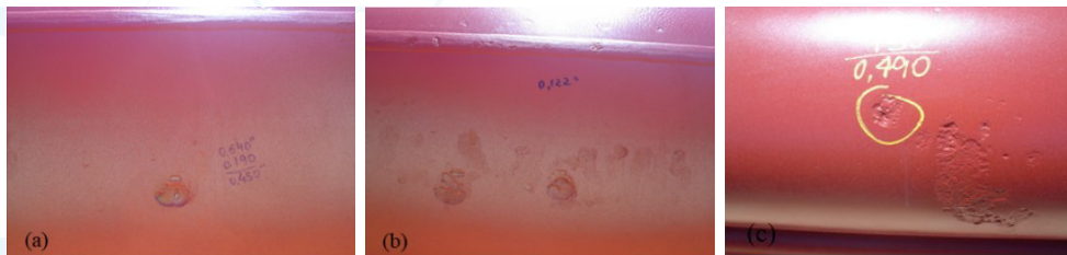
Figura 1: (a, b, c) Defeito de corrosão
