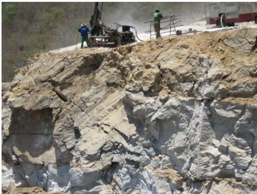
Figura 1. Operação de perfuração de rochas com perfuratriz pneumática
