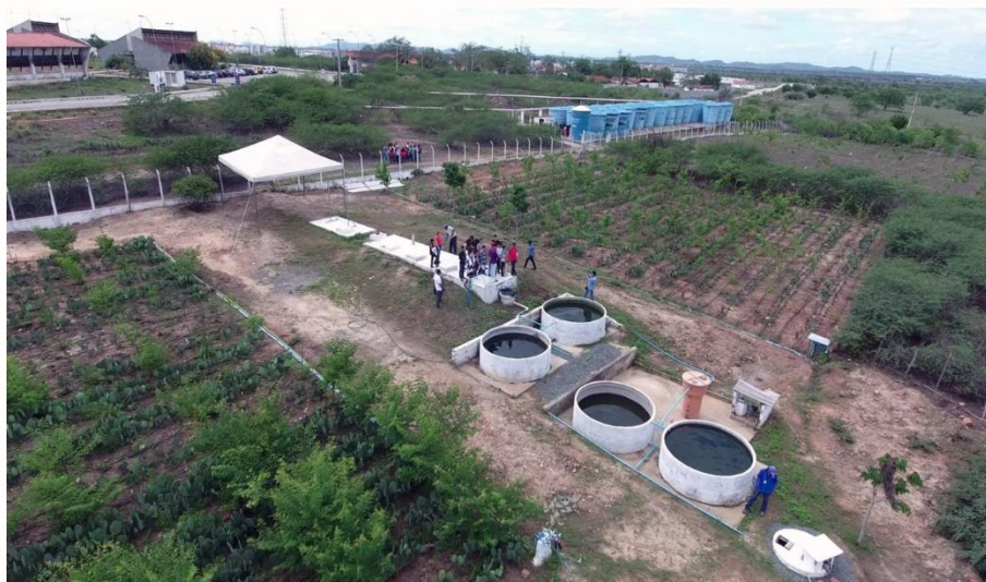
Figura 3 – Visão panorâmica do sistema de tratamento de esgoto. Foto: Felipe Lavorato (INSA).
