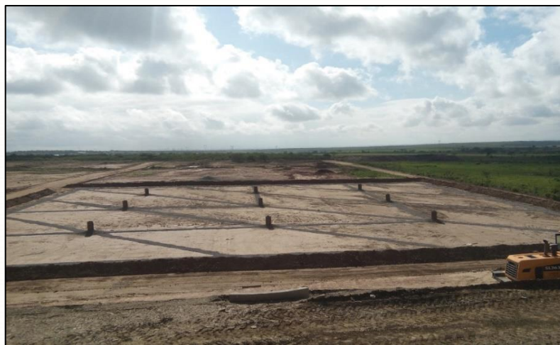
Figura 4: Lagoas de evaporação para contenção do lixiviado
