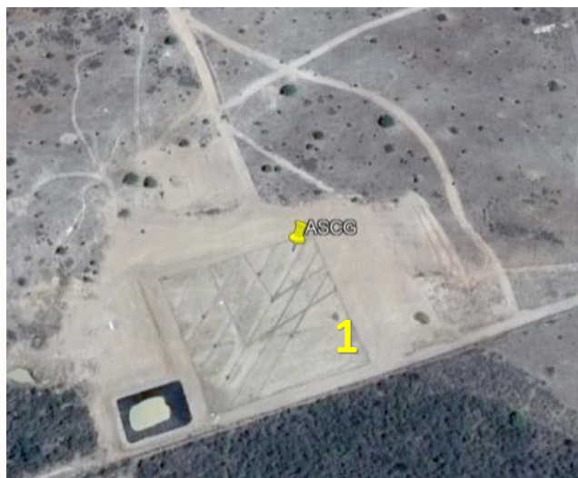
Figura 5: Vista de satélite do ASCG em abril de 2015: Construção da rede de drenagem da Célula 1
