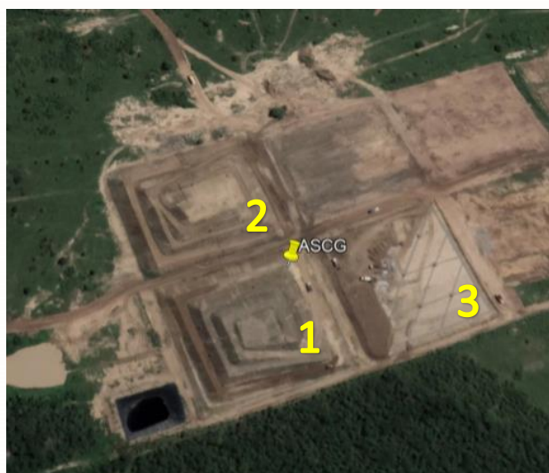
Figura 6: Vista de satélite do ASCG em maio de 2016: Células 1 e 2 concluídas e início de montagem da rede de drenagem da Célula 3.
