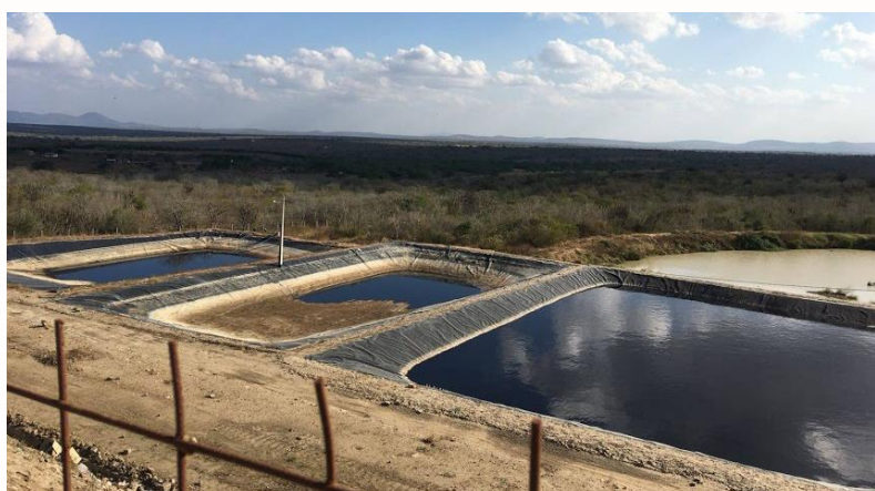
Figura 4: Lagoas de evaporação para contenção do lixiviado
