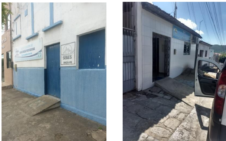
Figura 18 e 19 – Imagens das rampas 02 e 08, respectivamente, do trecho em estudo.
