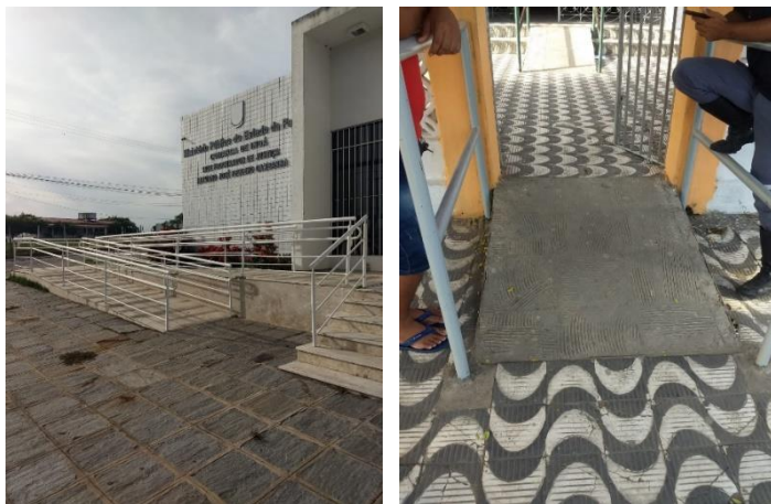
Figura 16 e 17 – Imagens das rampas 13 e 15, respectivamente, do trecho em estudo.
