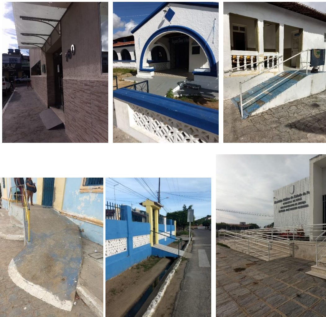
Figura 03, 04, 05, 06, 07 e 08 – Imagens de rampas do trecho em estudo.
