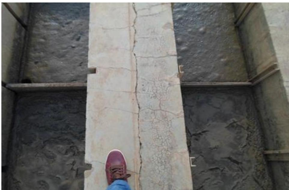
**Figura 1** Fissuras nas estruturas dos tanques
