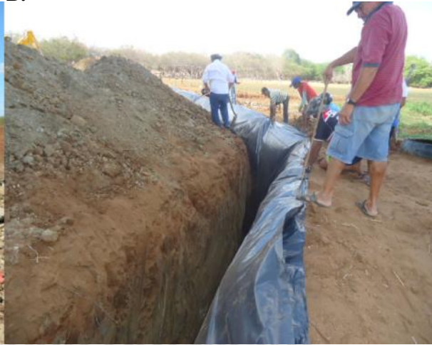
Figura 2. (A) Construção de Cisterna de placa, Pararí-PB. (B) Colocação da lona na construção de Barragem Subterrânea, Pararí-PB.
