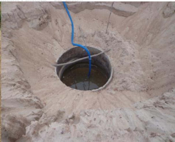
(C) Perfuração de poço à cata-vento, Pararí-PB. (D) Poço Amazonas construído no Rio Taperoá, Pararí-PB.
