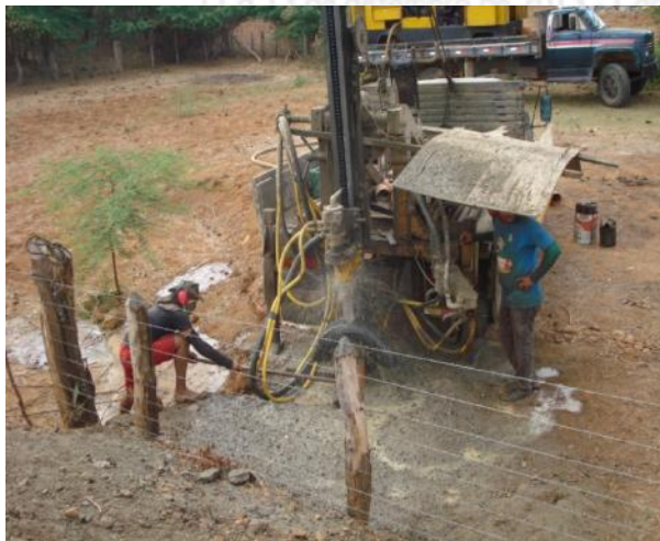
(C) Perfuração de poço à cata-vento, Pararí-PB. (D) Poço Amazonas construído no Rio Taperoá, Pararí-PB.
