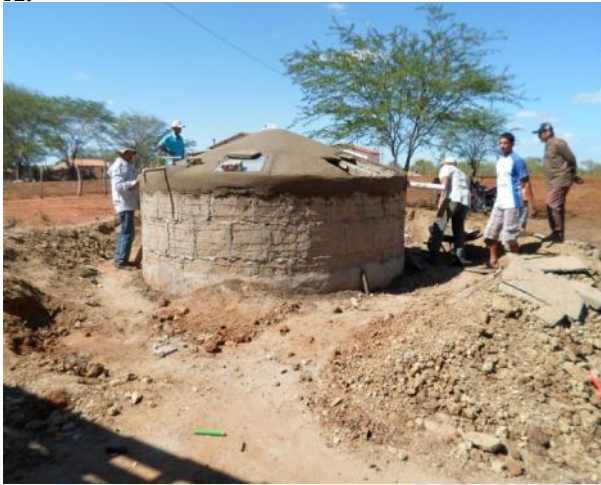
Figura 2. (A) Construção de Cisterna de placa, Pararí-PB. (B) Colocação da lona na construção de Barragem Subterrânea, Pararí-PB.
