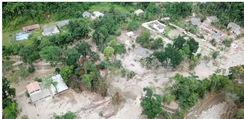
Foto 1. Casas atingidas por grande carga de sedimentos na margem esquerda do rio Bracuí, em janeiro de 2024, no setor mais à montante do trecho atingido pelo desastre, Angra dos Reis (RJ).
