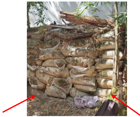
Figura 1 – Obras de Contenção de erosão na margem esquerda do canal
