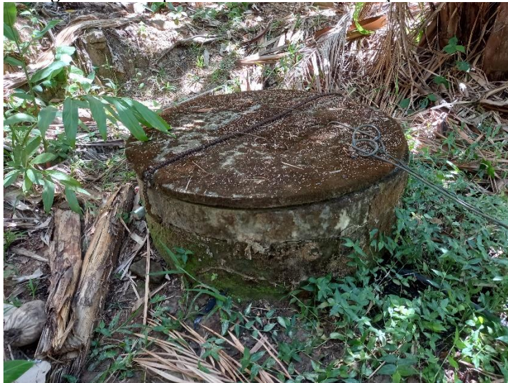
Figura 2 – Exemplo de nascentes com intervenção estrutural
