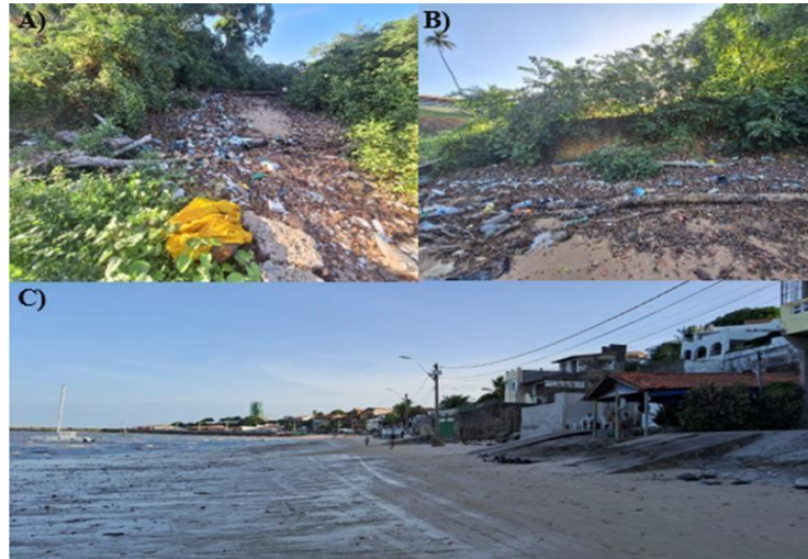
Figura 3: a) Deposição inadequada de resíduos sólidos; b) Erosão e resquícios de intemperismo; c) Habitações na costa adjacente à praia em São José de Ribamar, Maranhão.
