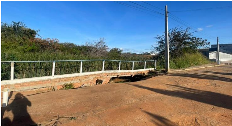
Imagem 2 - Ponte no perímetro urbano da BA-156
