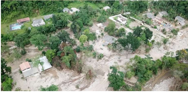
Foto 1. Sedimentação na margem esquerda do rio Bracuí, em janeiro de 2024, no setor mais a montante o trecho atingido pelo desastre, Angra dos Reis (RJ).
