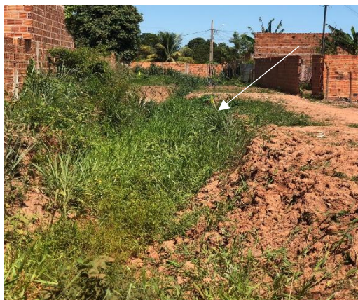
Figura 4: Valeta construída para a drenagem pluvial no bairro Espírito Santo
