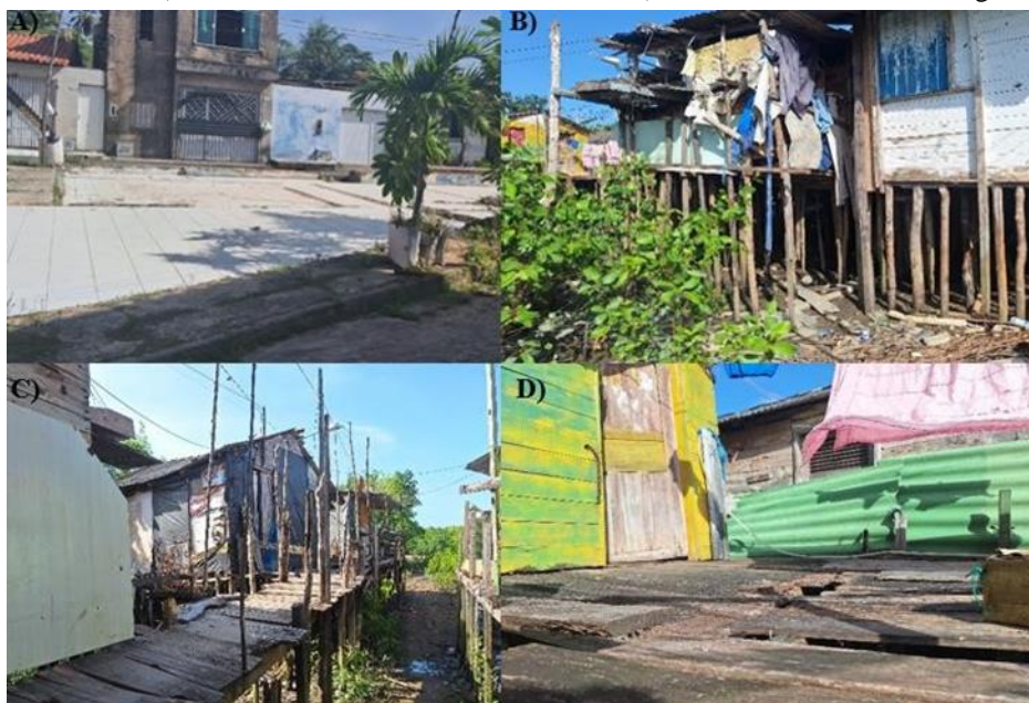
Figura 02: Vista parcial das edificações do bairro do Vieira, em São José de Ribamar A) Casas localizadas na área alta B) Estearias nas áreas de mangue
