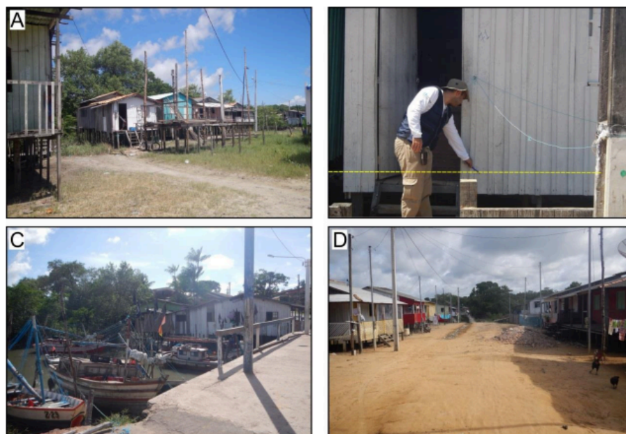
Figura 3 - (A) Casas em palafitas no bairro Guarani. (B) A linha amarela representa o nível que a inundação atingiu em abril de 2016. (C) Casas nas margens dos igarapés que cortam o mangue. (D) Aterro para assentamento de rua. Fonte: CPRM, 2016.
