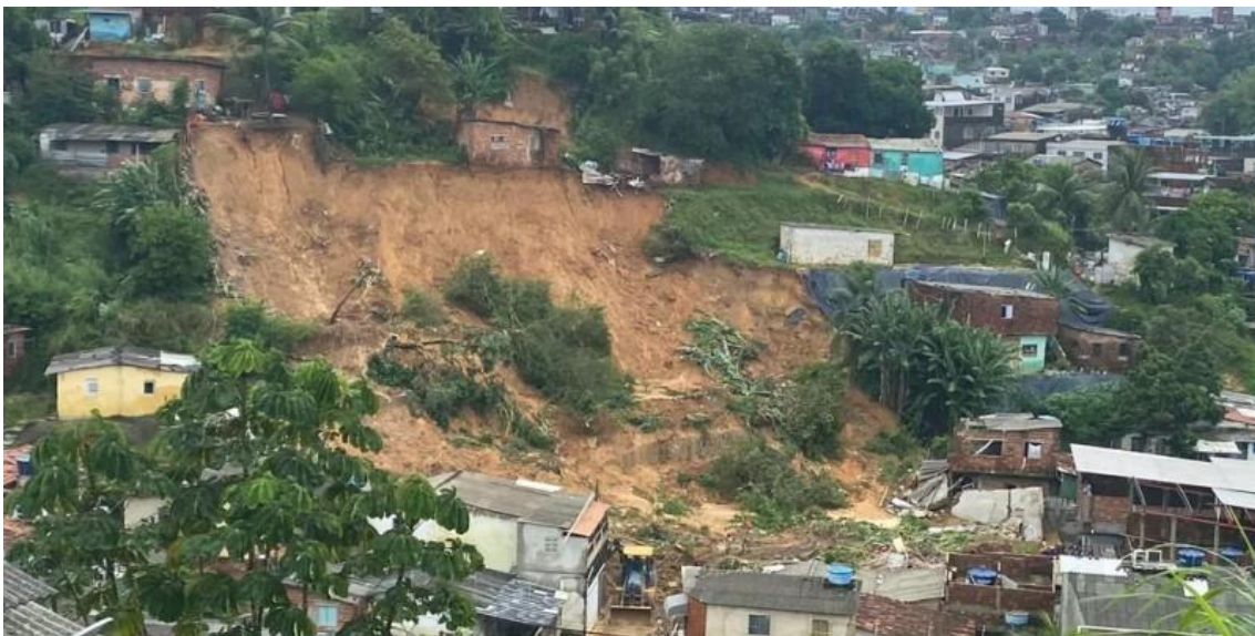
Figura 1: Registro de escorregamento ocorrido em Jardim Monte Verde, Jaboatão dos Guararapes/PE.
