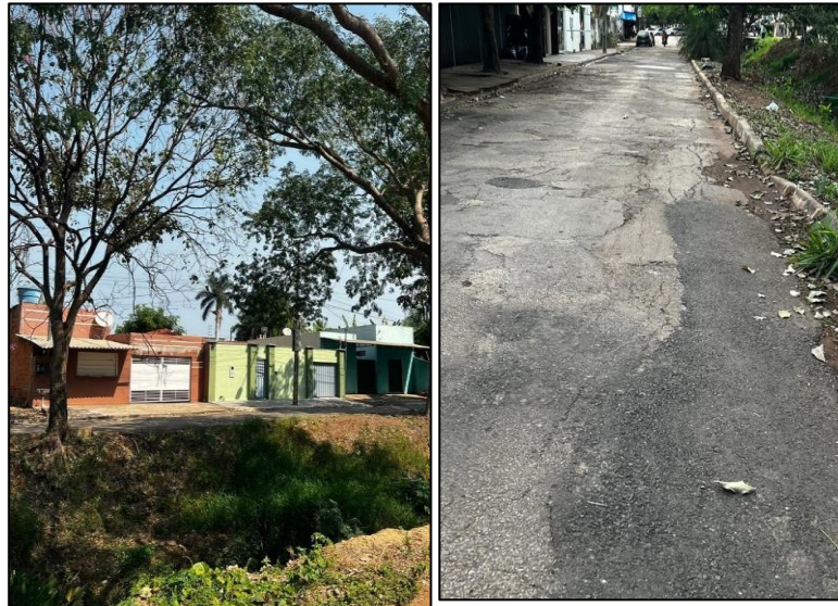
Figura 06 Habitações na margem do córrego e destruição asfáltica.
