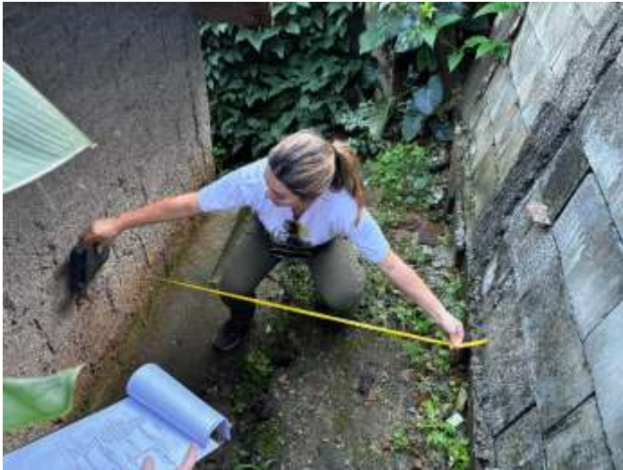
Figura 2: Registro fotográfico durante a avaliação de risco em moradia na Comunidade da Servidão dos Lageanos em maio de 2024, após deslizamento e deslocamento do muro, resultando em apenas um talude de corte com distância entre muro e moradia de 1,23m. Fonte: Os autores.
