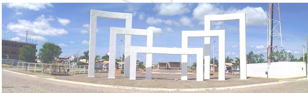
Figura 1 – Vista do Pórtico da Praça de Eventos, Pau dos Ferros – RN.
