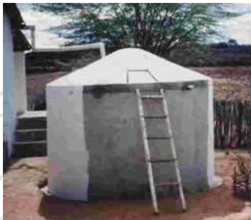
Figura 04: Tanque de armazenamento de água de teto cônico. Fonte: Gnadlinger (1999)
