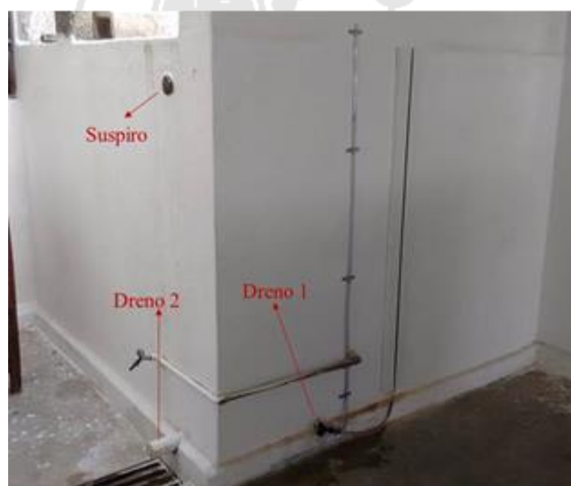
Figura 02: Tanque de armazenamento de água em estudo.
