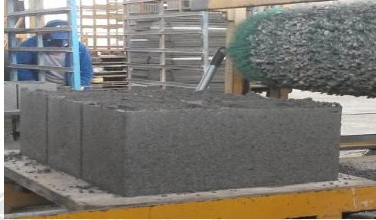
Figura 3: Moldagem dos blocos de concreto
