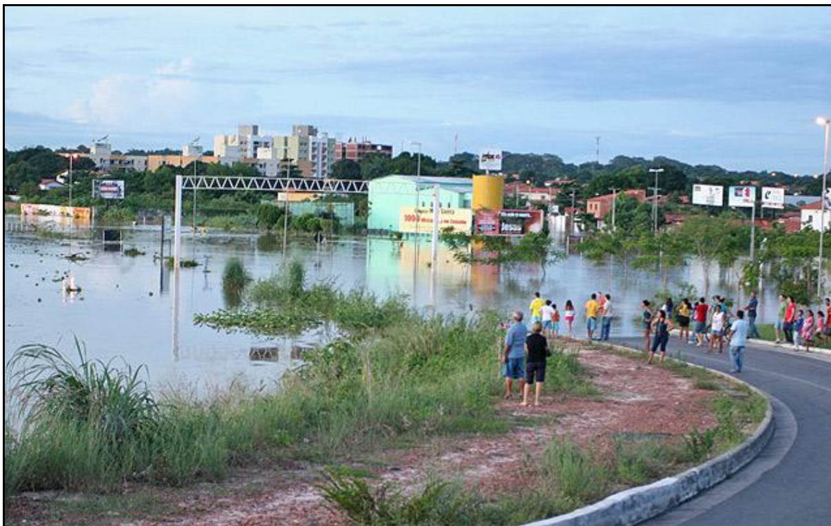
Figura 7. Ponte Wall Ferraz interditada, Bairro dos noivos, Zona Leste de Teresina (2009).
