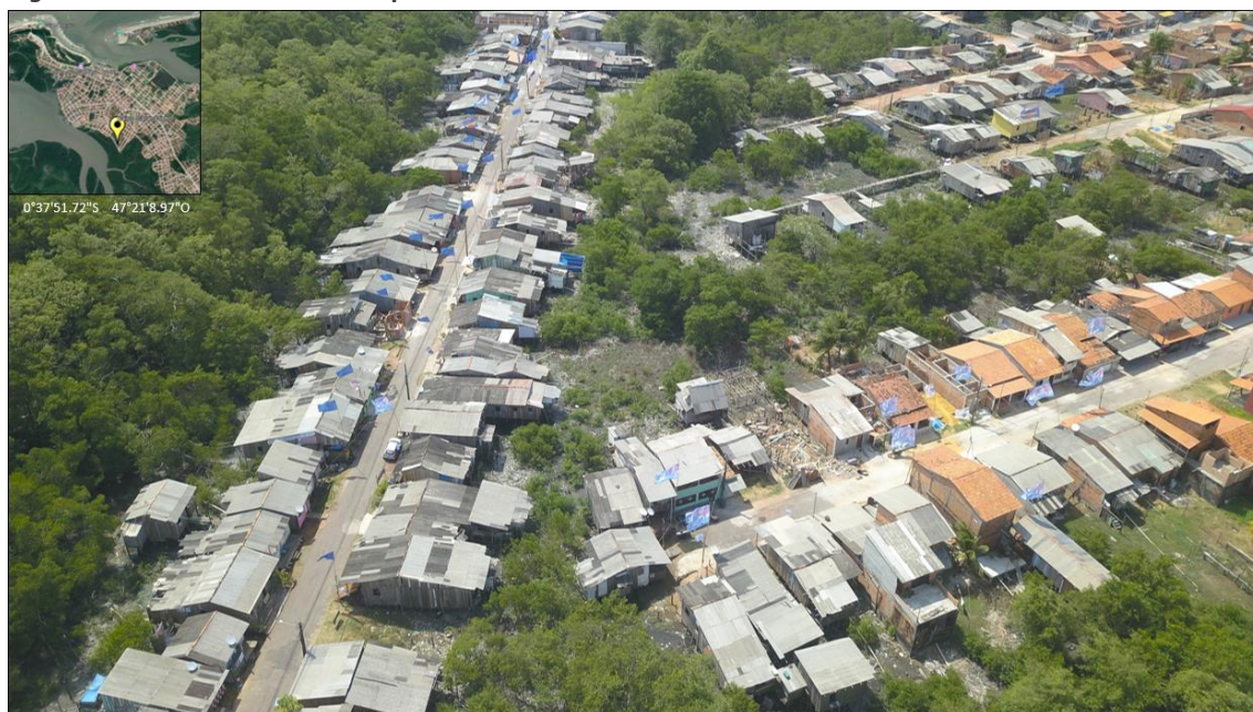
Figura 7: Estruturas habitacionais precária do bairro Caranãzinho.
