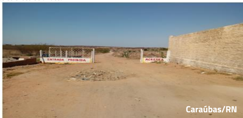
Figura 4: Acessos às áreas de lixões.
