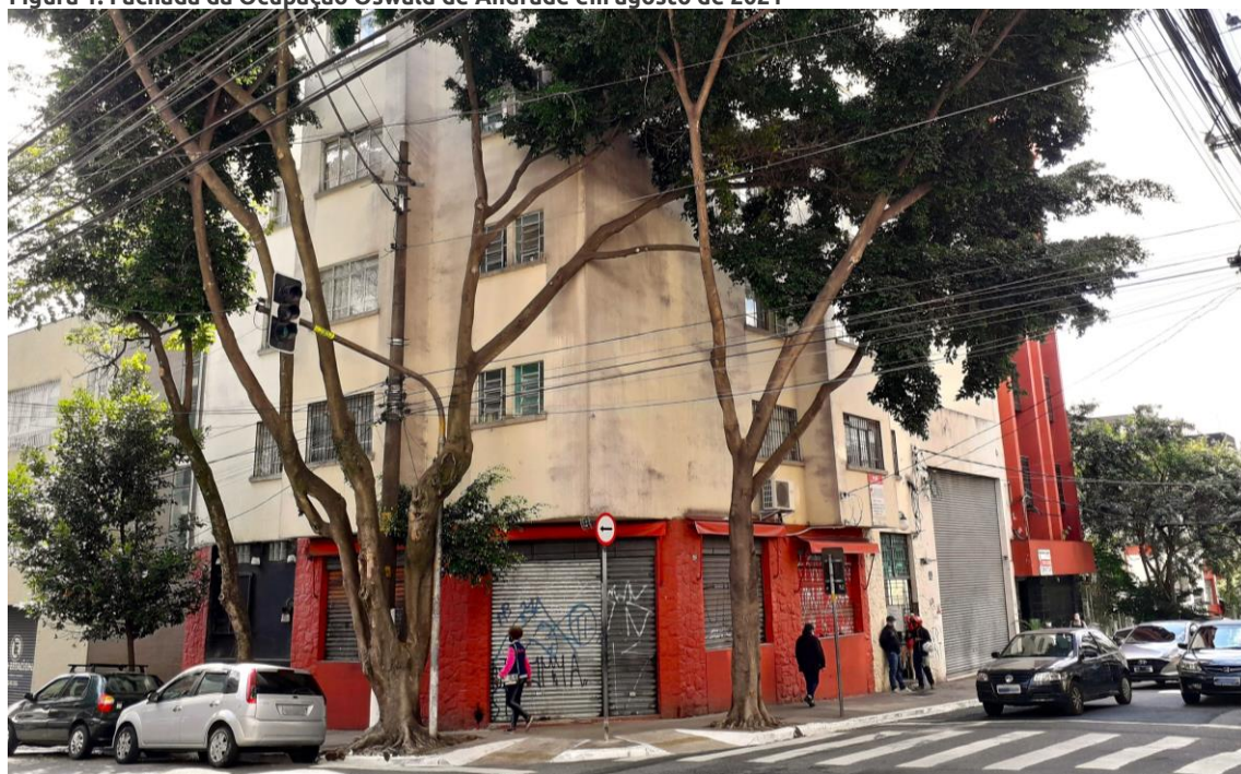
Figura 1: Fachada da Ocupação Oswald de Andrade em agosto de 2021
