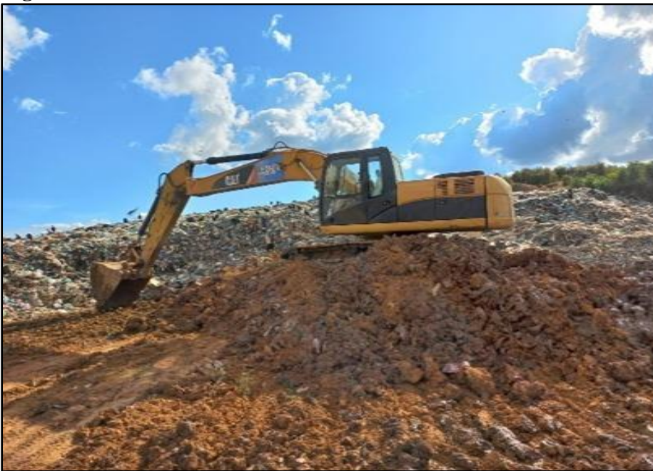
Figura 4: Tratamento dos resíduos sólidos em célula no aterro sanitário
