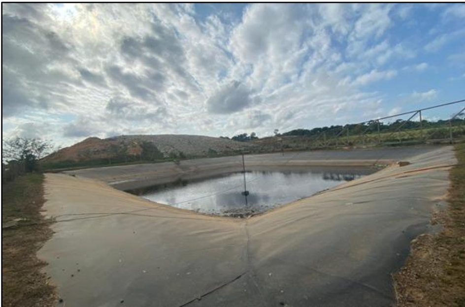
Figura 5: Lagoa de acúmulo de chorume do aterro sanitário.
