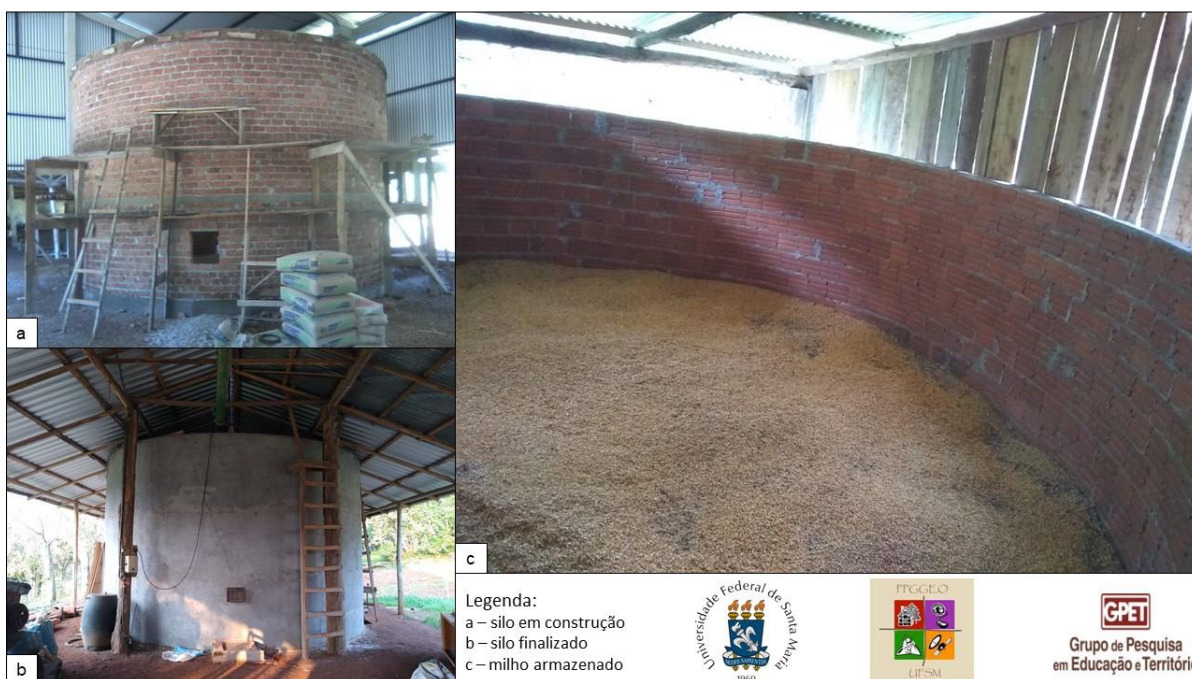
Figura 10 – Etapas da construção dos silos para secagem e armazenagem nos estabelecimentos
