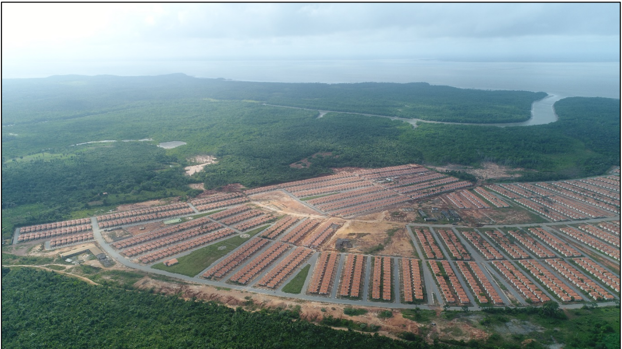
Figura 6: Vista área parcial do conjunto habitacional Mato Grosso
