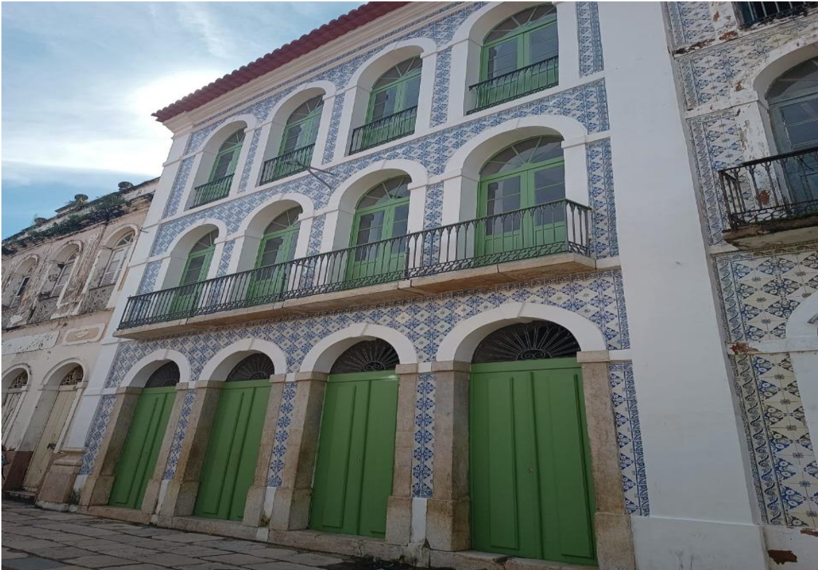
Figura 3 – Casarão de três pavimentos no Centro de São Luís (2023).
