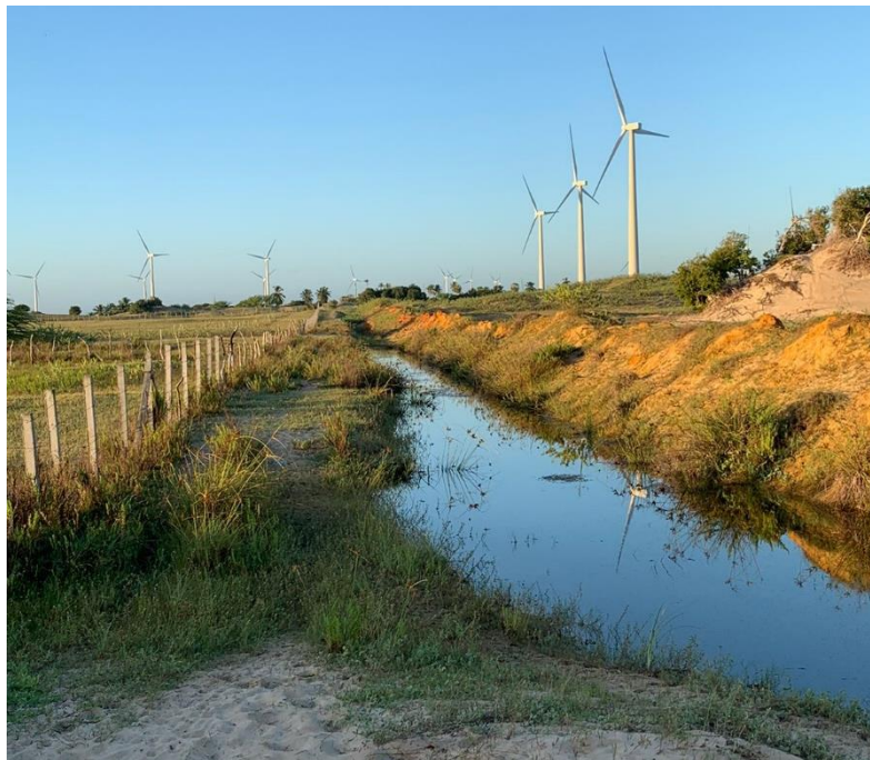
Figura 03: Vala construída pela empresa desenvolvedora do projeto como forma de bloqueio de acesso à área interna do complexo eólico e à Praia da Barra.
