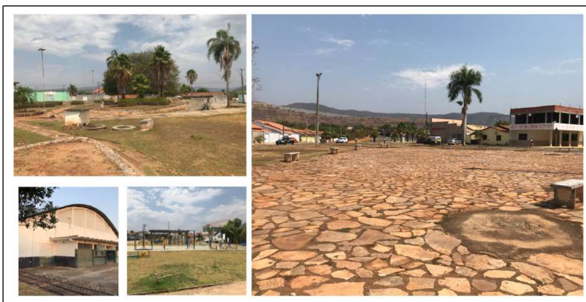
Figura 5 – Condições infraestruturais e de conservação de praças, ginásio esportivo e parque infantil de Minaçu-GO
