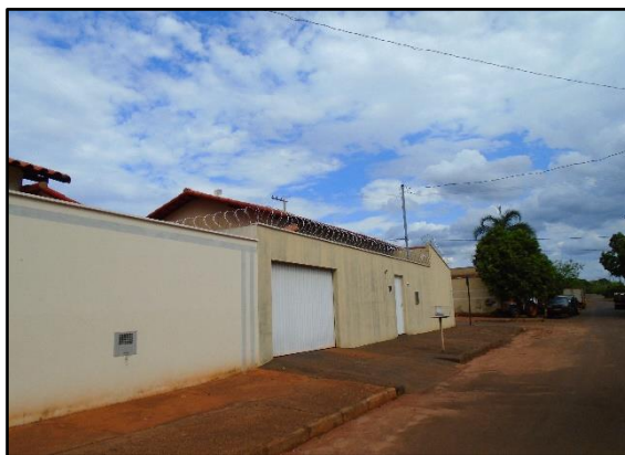
Figura 2 – Residencial Canaã: presença de muros e concertinas - 2019
