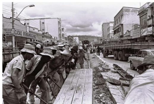
Figura 10: Foto mostrando a retirada dos trilhos- ano de 1975.
