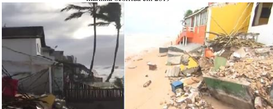
Figura 5 – Imóveis atingidos na praia de Arembepe por conta da ressaca marinha ocorrida em 2019
