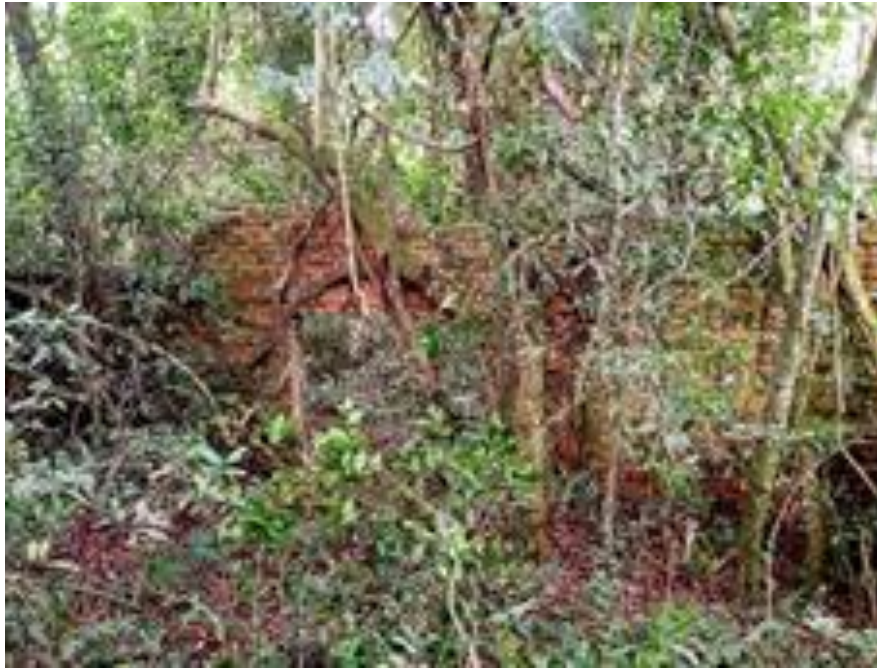
Figura 8: Ruínas da casa de força. Data: maio de 2021.
