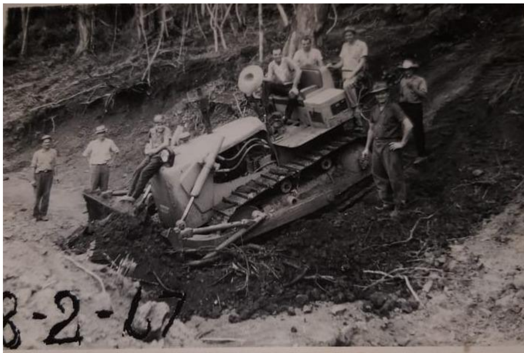
Figura 3: Escavação de canais na mini usina em Maripá. Gentileza de Durval Conci.
