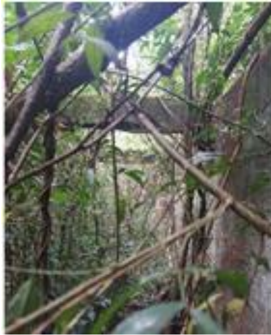
Figura 6: Ruínas da câmara de carga. Data: maio de 2021.
