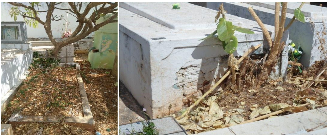
Figura 4: Raízes invadindo o espaço de sepulturas no cemitério São Sebastião na zona urbana de Mossoró/RN. Fonte: Aatoria (2020).
