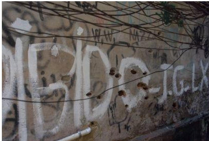
Figura 5: Buracos de bala em uma parede da favela. Foto: Leonardo Carrato
