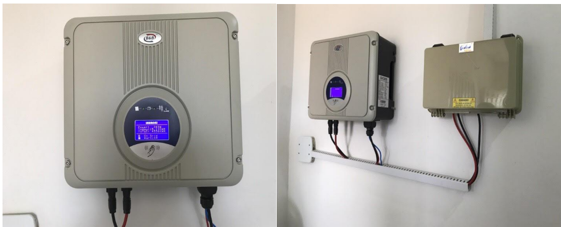
Figura 4 - Armazenador de energia fotovoltaico – capacidade 400 kWh mês
