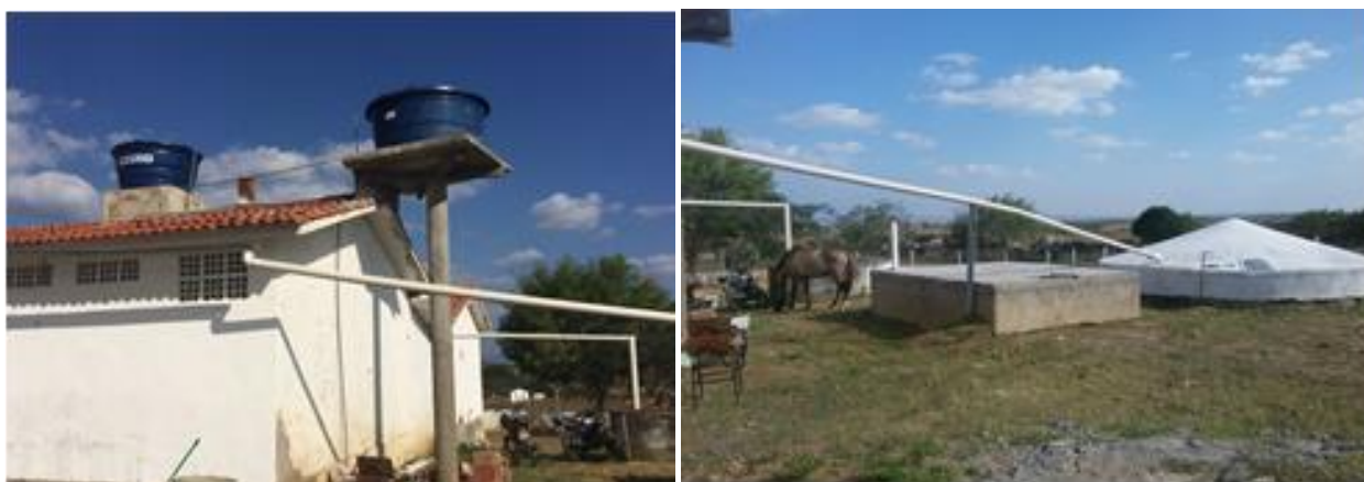
Figura 2 - Cisterna com sistema de captação de água das chuvas na escola da zona rural de Queimadas-PB.
