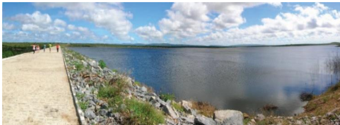
Figura 5: Vista da barragem do mucutu, após sua inauguração. Fonte: (SMARH , 2002)
