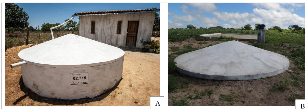
Figura 6 A) Cisterna de placa que capta água pelo telhado para consumo da famílias com capacidade de 16 mil litros; B) cisterna calçadão com capacidade de 52 mil litros e voltada para produção agrícola. Fonte: Jornal Pinheiro,(2019)
