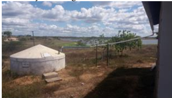
Figura 01: Encanação interligando a calha da residência à cisterna
