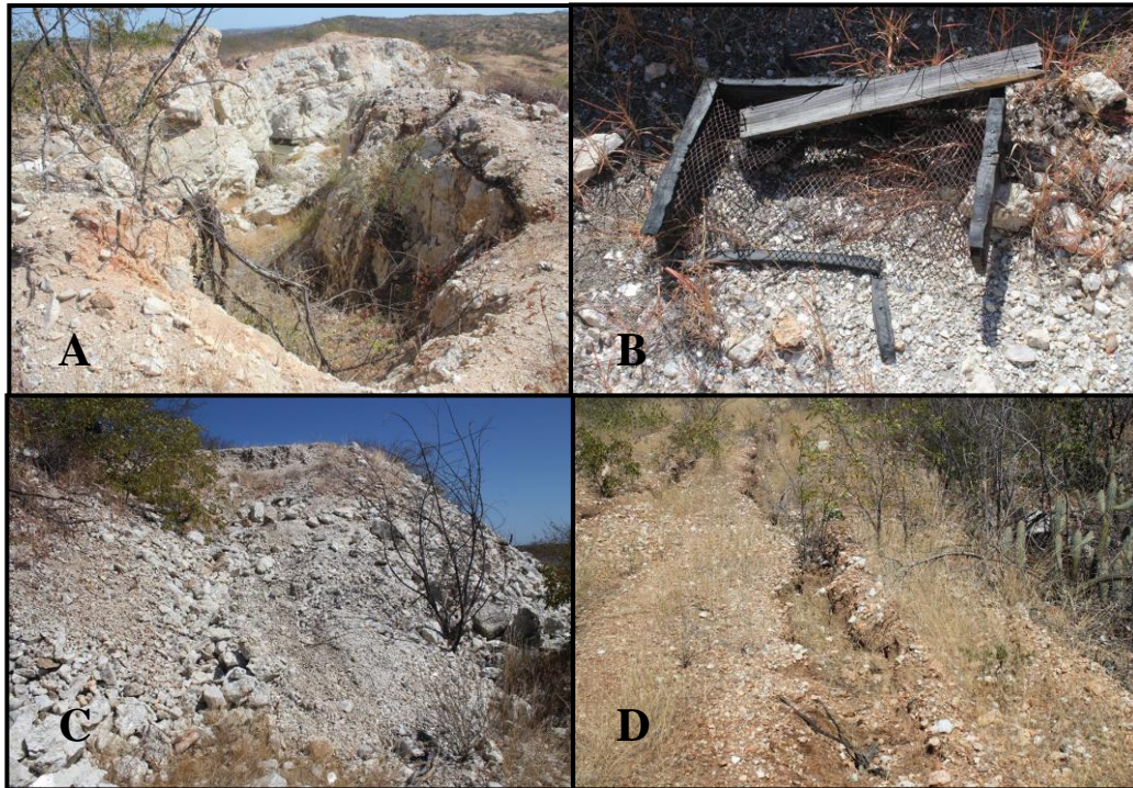
Figura 6: Impactos ambientais identificados no garimpo Lagoa do André 2. (A) Risco de desmoronamento dos taludes; (B) Pilhas de estéril; (C) e (D) Processos erosivos.
