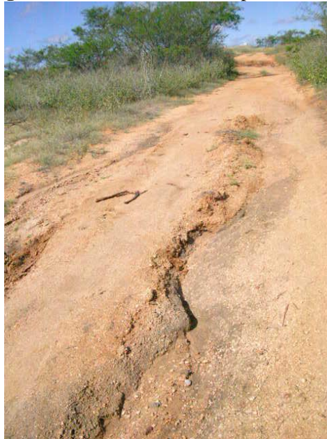
Figura 3: Sulco com 21cm de profundidade
