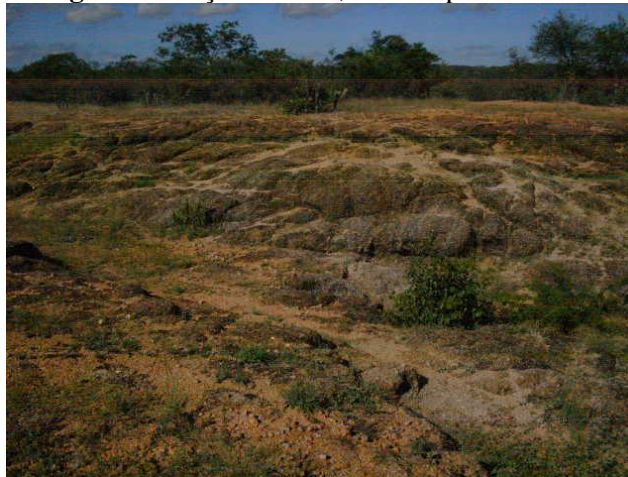
Figura 5: Voçoroca de 2,5 cm de profundidade
