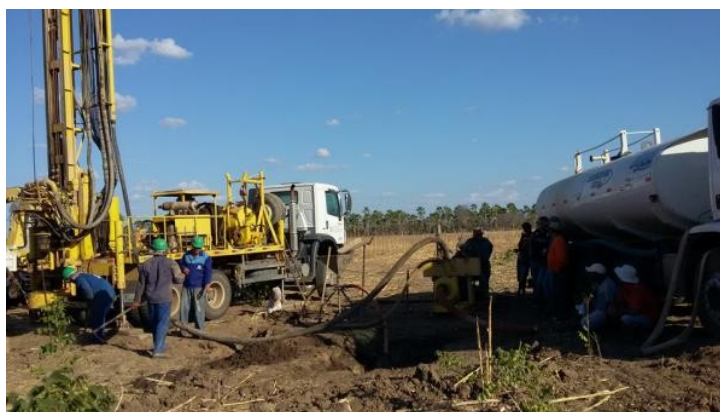
Figura 03 - Poço perfurado no Canto do Pintos
