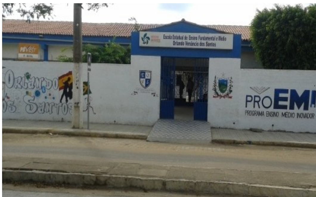
Figura 1. Fachada da escola campo de pesquisa – E.E.E.M. Orlando Venâncio dos Santos, município de Cuité-PB.
